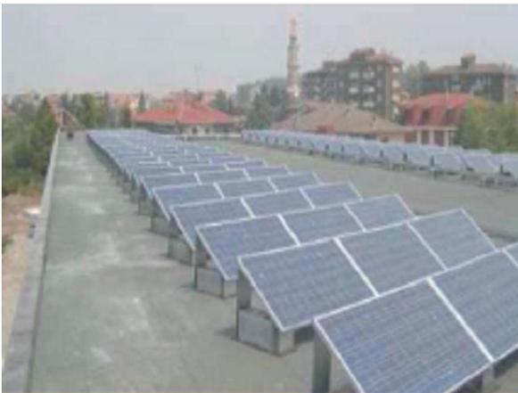
Figura 1: Installazione di pannelli fotovoltaici su lastrico solare
